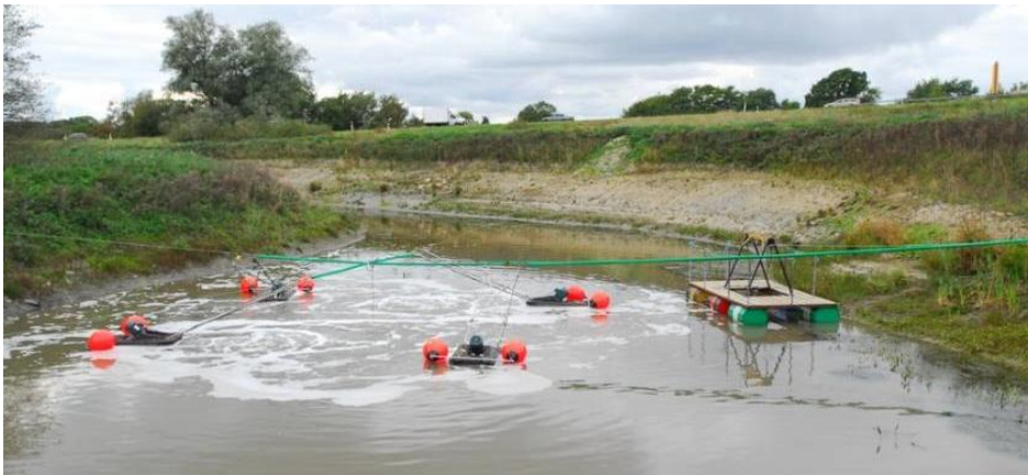
Figur 4.4 Utjämningsmagasin för dagvatten
