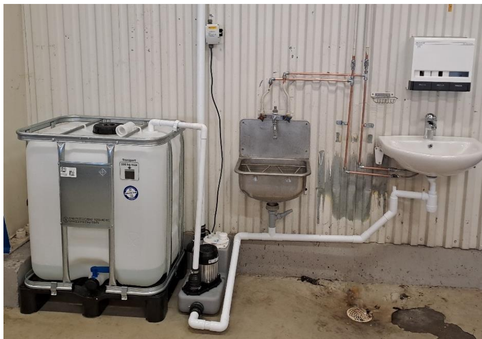
Åtgärd i byggnad 24
